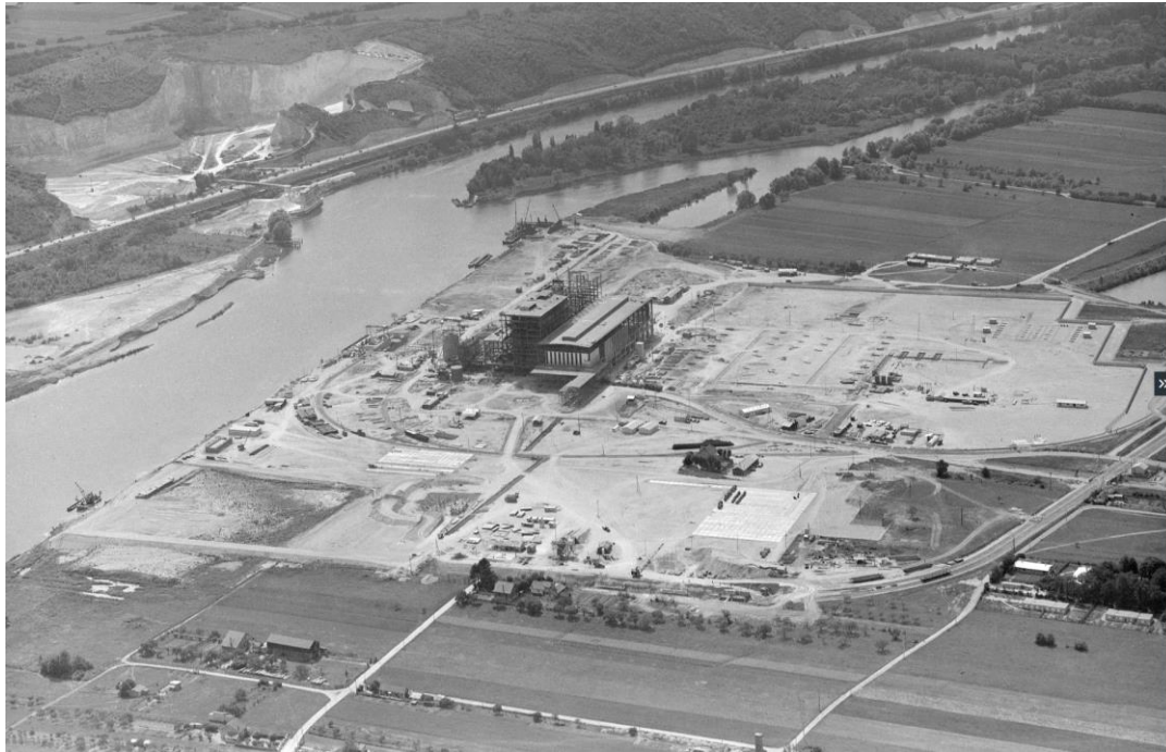
Construction de la centrale charbon en 1955
