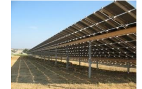
Structures fixes inclinées
