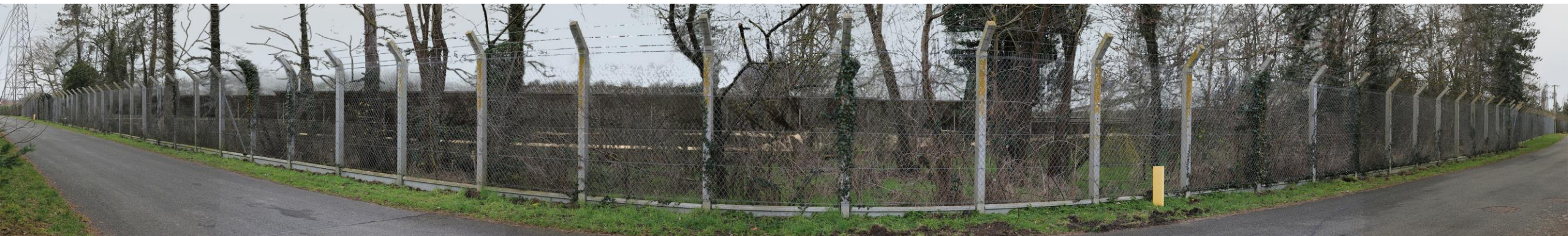
Photomontage du projet depuis la rue de la Grande remise (sans mesures paysagères) – version de travail :
