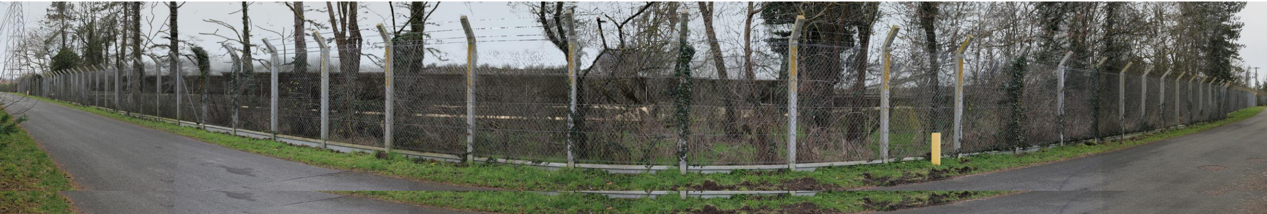
Photomontage du projet depuis la rue de la Grande remise (sans mesures paysagères) – version de travail :
